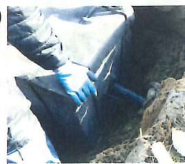
排水配管接続部分
