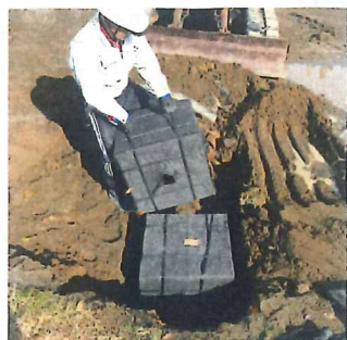
設置の様子(人力で運搬)
